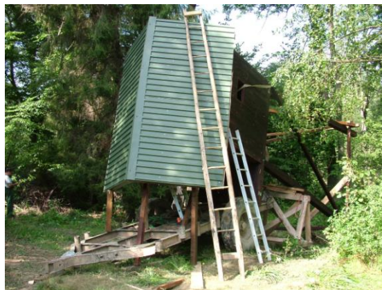
Fot. 8. Montaż połaci dachowych
