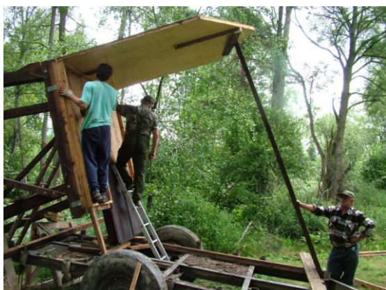
Fot. 5. Montaż ściany tylnej
