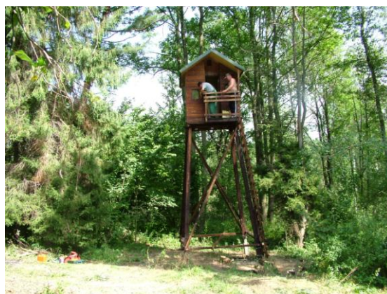
Fot. 10. Prace na balkonie
