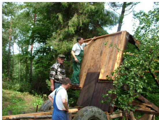
Fot. 4. Przytwierdzanie podłogi do słupów
