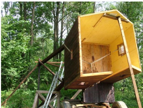
Fot. 7. Wstawianie ścianek przednich
