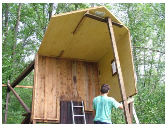
Fot. 6. Łączenie ściany prawej
